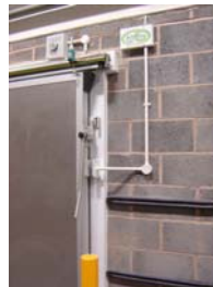
Actual RHS placement
